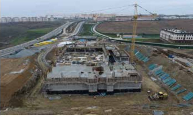
Toplam inşaat alanı 9.550 m 2 olan İbn-i Haldun Üniversitesi Spor Merkezi inşaatı devam ediyor. (İstanbul/Başakşehir)
